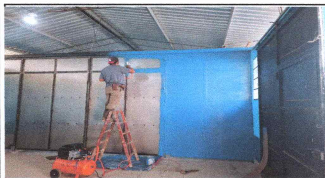
Foto 3: COLOCACION DE PORTONES ABATIBLES EN EL MODULO DE PREPRIMARIA
