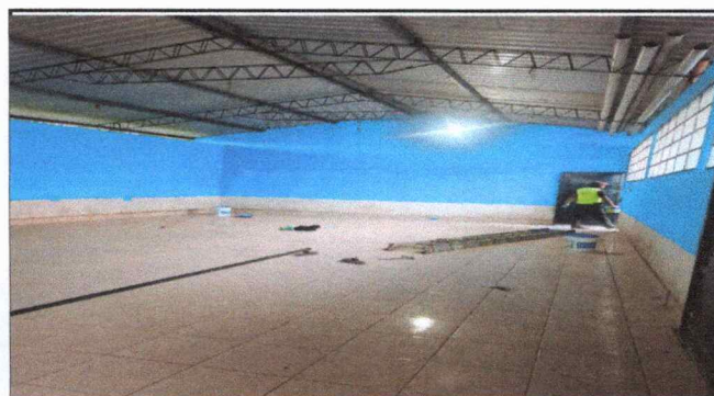
Foto 4: REPARACION DEL SISTEMA ELECTRICO EN EL MODULO DE PREPRIMARIA
