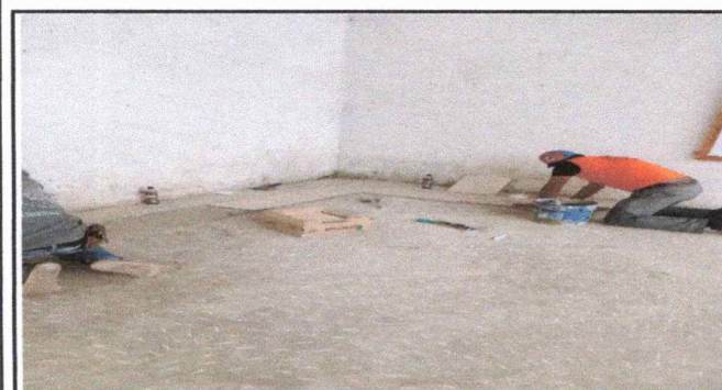
Foto 5: COLOCACION DE PISO CERAMICO EN EL MODULO DE PREPRIMARIA
