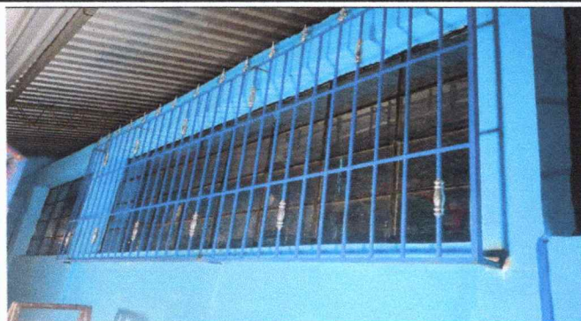
SUSTITUCION DE VIDRIOS EN EL AULA DE CUARTO PRIMARIA
